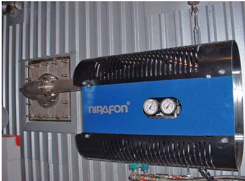
Pieni, torvineen 1550x550x450 mm:n kokoinen kaasupulssinuohoin on helppo sijoittaa ahtaaseenkin paikkaan. Kuvan nuohoin on asennettu tavalliseen miesluukkuun.
