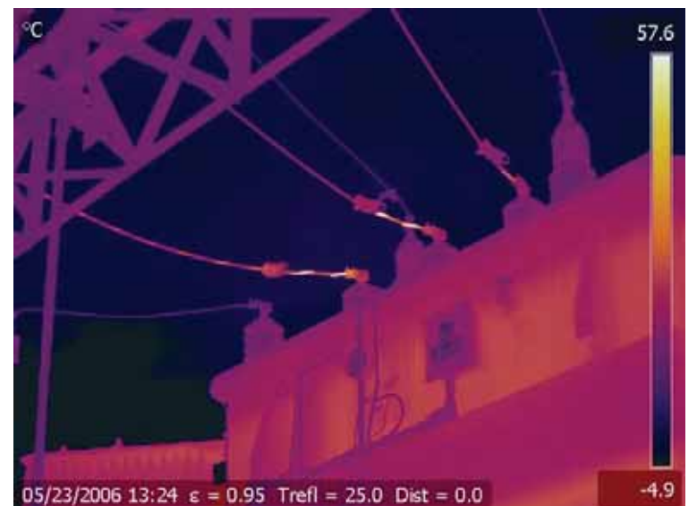
P640:lla otettu lämpökuvau
