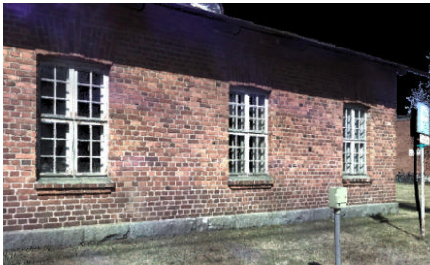
Tegemist pole halva kvaliteediga digifotoga vaid punktipilvega, millele on lisatud naturaalsed värvid, mis on üles võetud laserskanneri oma kaameraga. Igal pikselil sellel pildil on täpsed koordinaadid, mille põhjal võib moodustada ehitisest arvuti abil mudeli.
